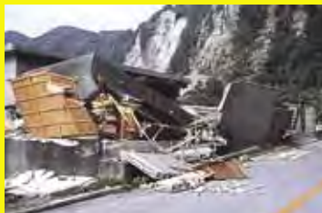
火山性の地震により倒壊した家屋(平成12年6月 東京都新島村)
