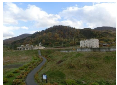
熱泥流に襲われた建物(遺構保存)
